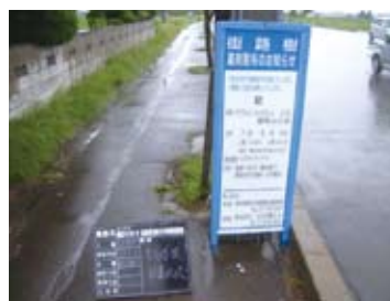
告知看板設置状況
