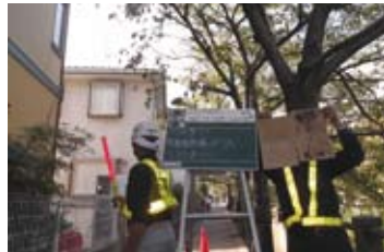
粘着板の交換作業
