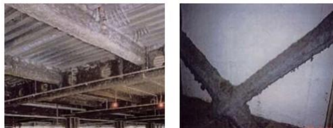
(吹付け石綿の施工例)
